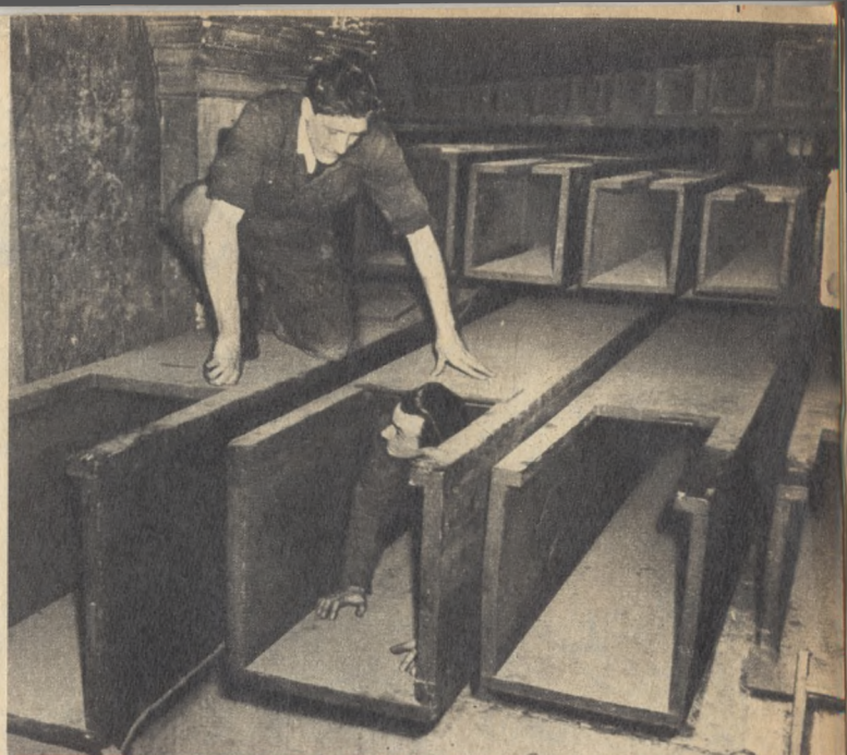
Les plus gros tuyaux doivent être nettoyés par un homme qui se met tout simplement à l'intérieur.
